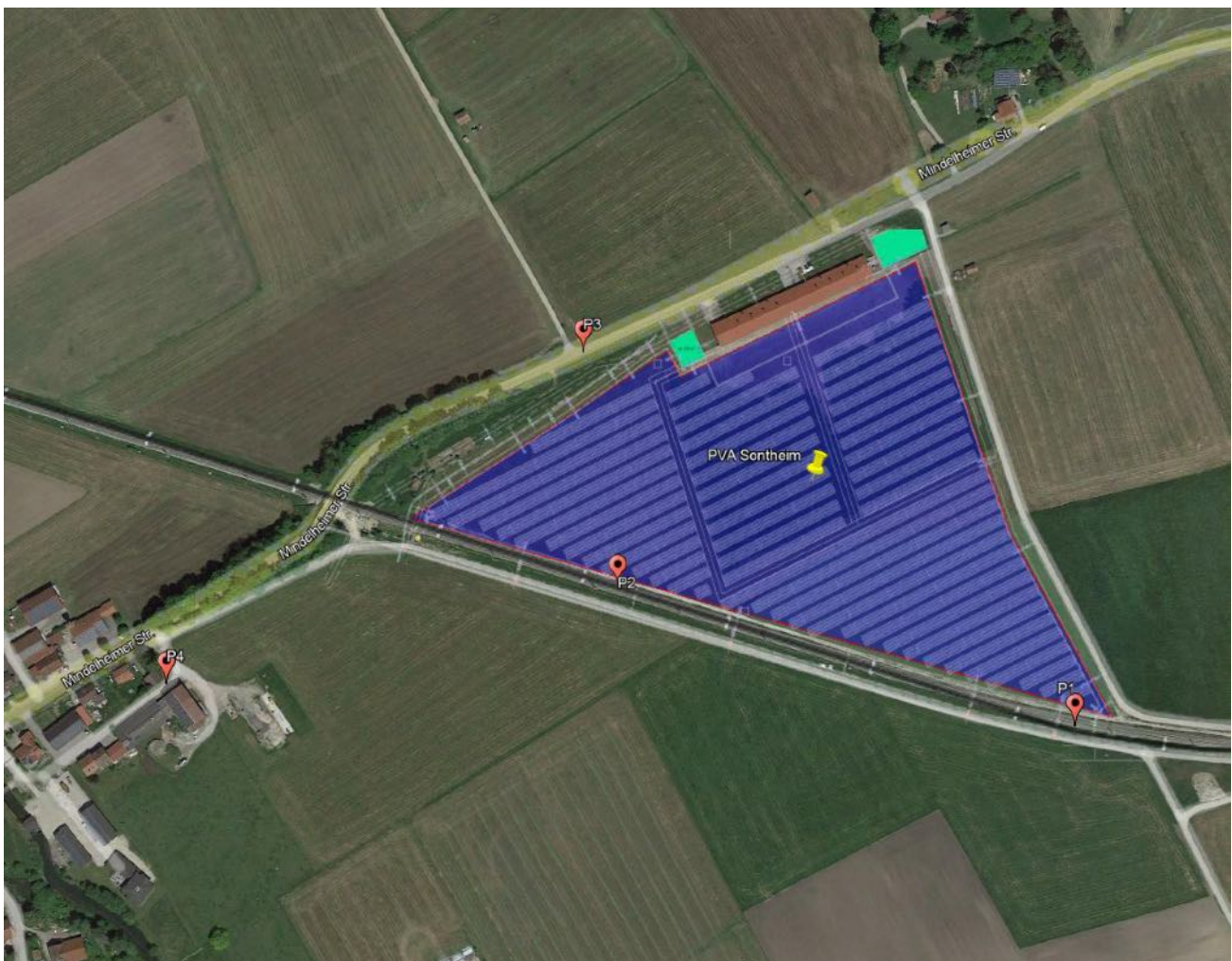
Bild 3.5.1: Übersicht über die PV Anlage und Messpunkte (Quelle: Google Earth/SolPEG)
